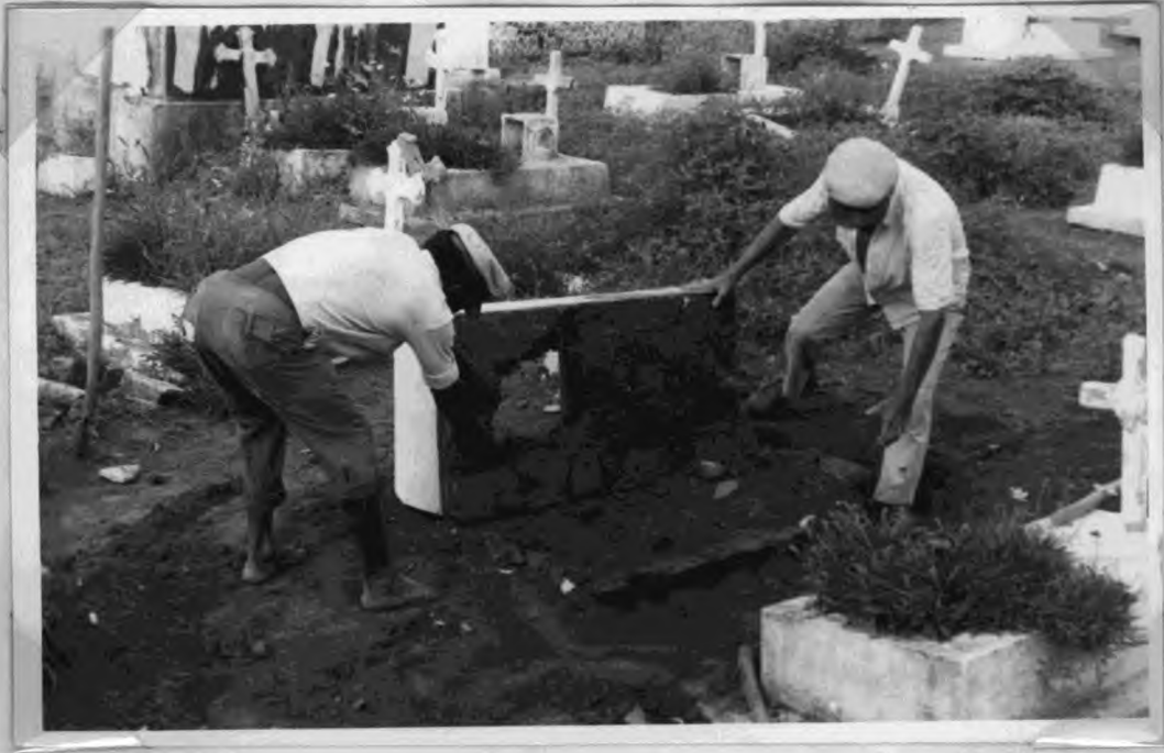
EMPREGADOS TRABALHANDO NA ESCAVAÇÃO
